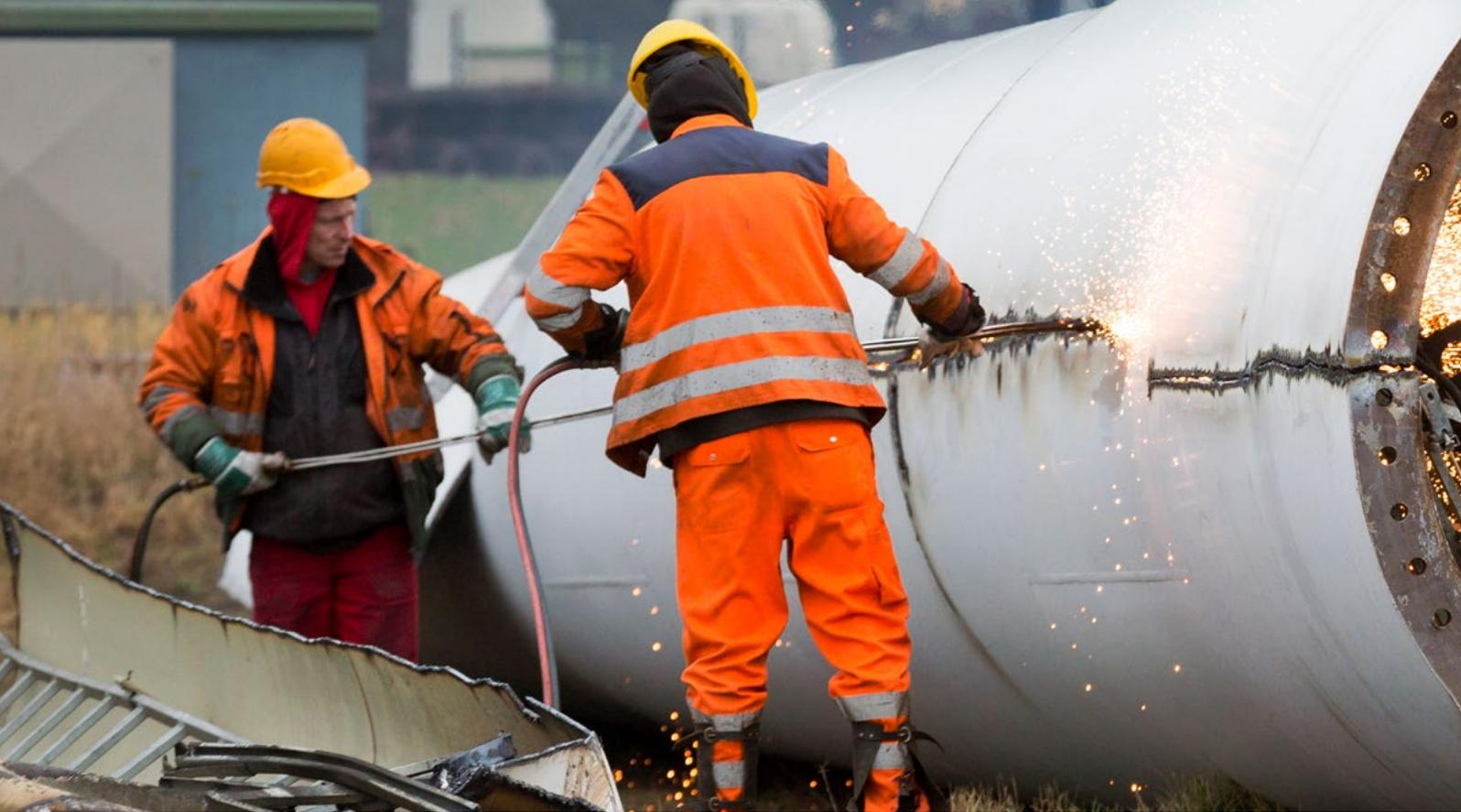
Zerschneiden der Turmsegmente nach Demontage einer Dewind-Windenergieanlage in Sachsen-Anhalt. © Paul Langrock
