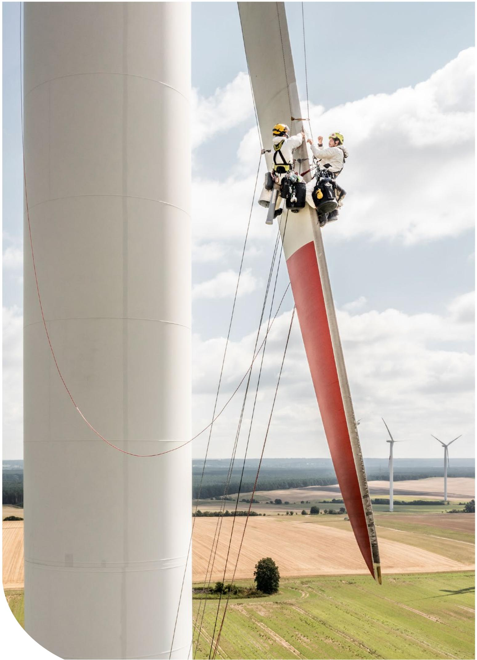
Abgeseilte Industriekletterer im Windpark Hohenselchow prüfen das Rotorblatt einer Windkraftanlage.
