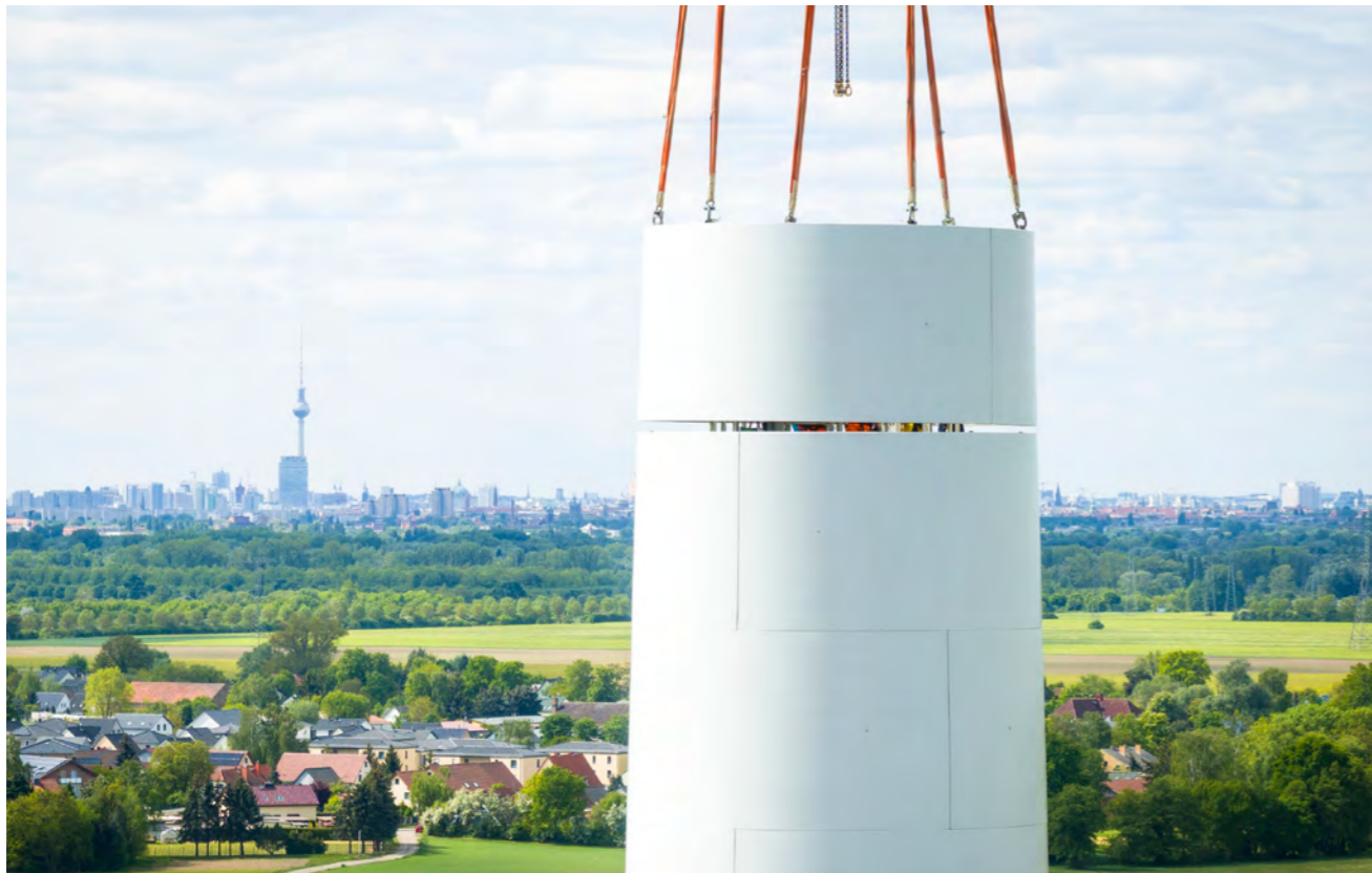
Mit einem Gewicht von bis zu mehreren hundert Tonnen ist der Turm das größte und schwerste Teil einer Windenergieanlage.
