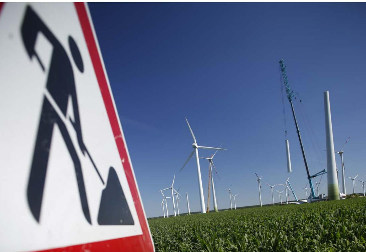
Repowering: Ältere 1-MW-Windenergieanlagen werden durch Enercon E-82 ersetzt. Foto: Jens Meier
