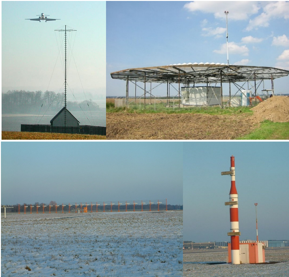
Abbildung 2: Konventionelle Funknavigationseinrichtungen (NDB, DVOR, LLZ, GP)
