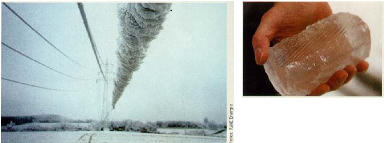
Abb. 16: links: Eisbehang eines abgerissenen Freileitungsseiles rechts: Eisklumpen mit Seilabdruck (Quelle: RWE AG)
