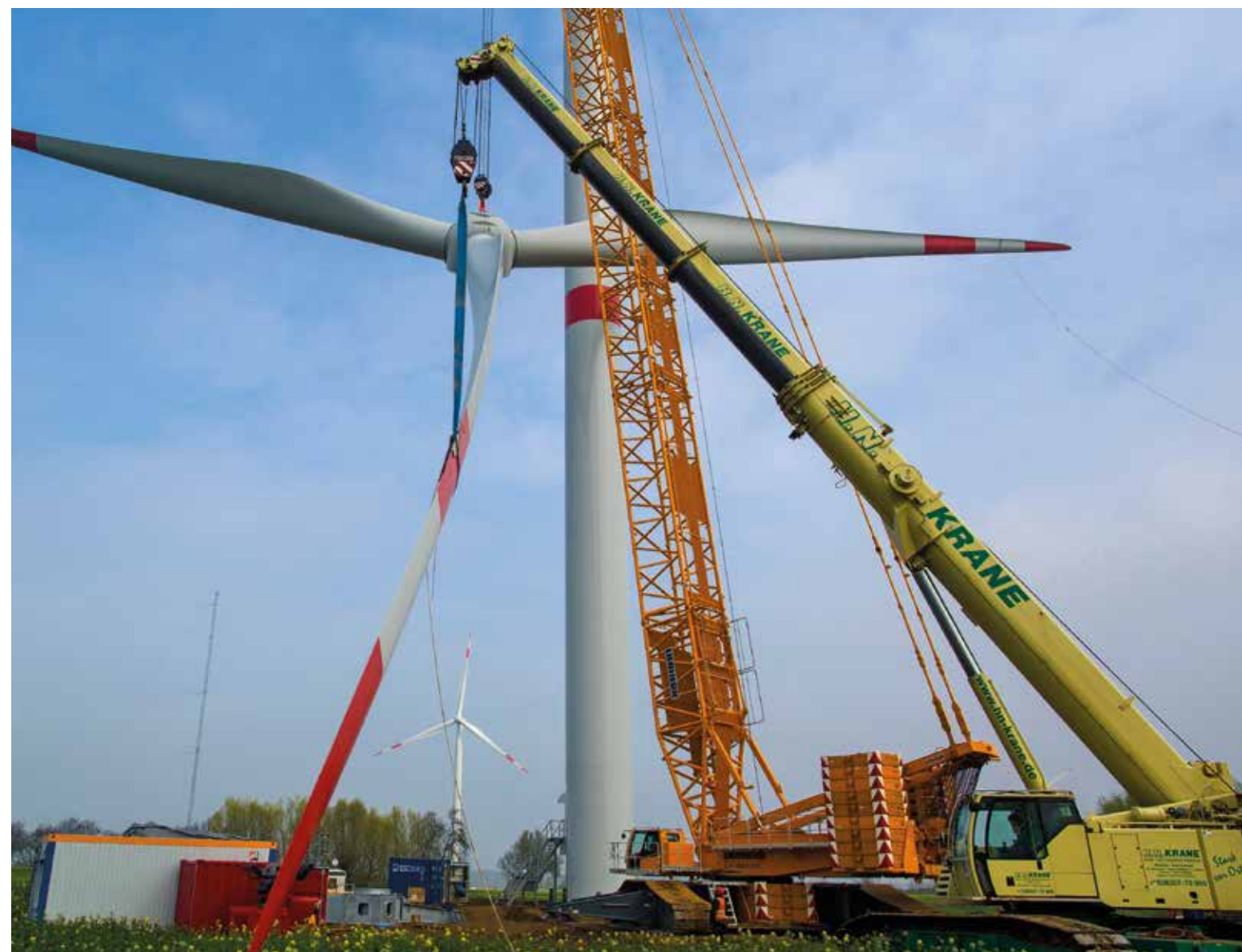
Gewohntes Bild: Der Rotorstern einer großen Windenergieanlage wird mit einem Kran auf den Turm gezogen
