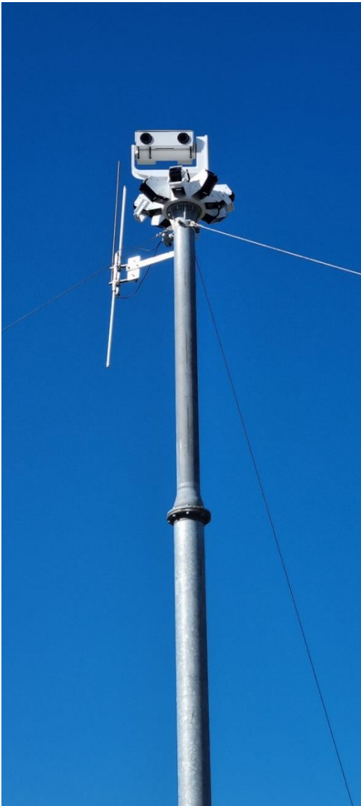
Abbildung 12: Abgespannter IDF Turm
