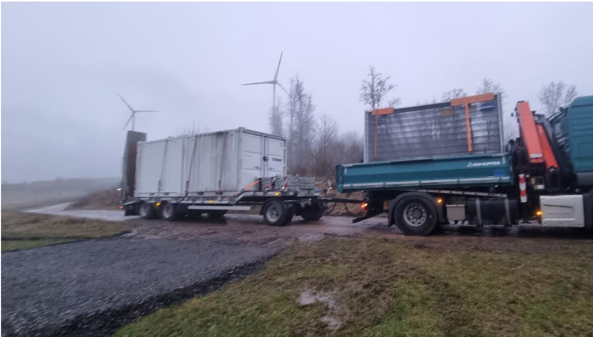
Abbildung 8: Anlieferung des IDF-1 über bestehende Straßen/Wege
