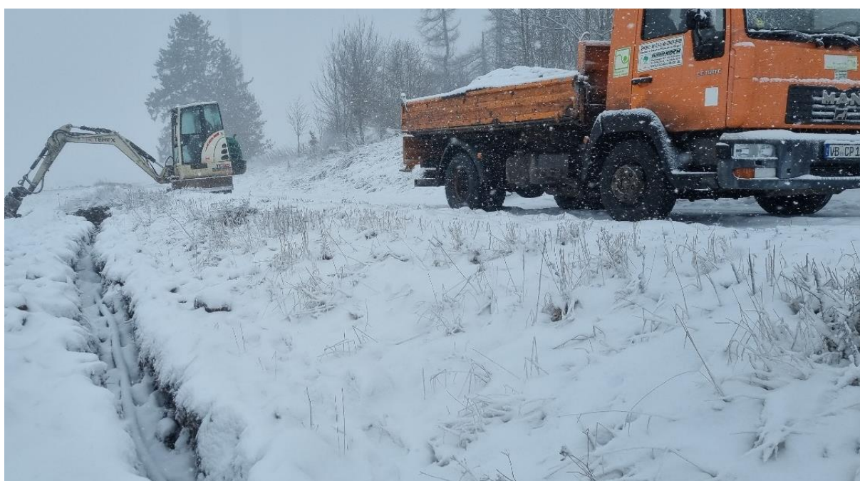
Abbildung 11: Schließen des Kabelgrabens zwischen beiden IDF Standorten
