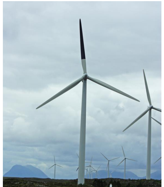
Testanlage im Windpark „Smøla“: Das äußere Dreiviertel eines Rotorblatts wurde schwarz lackiert, um die Wahrnehmung durch Vögel zu verbessern und so die Kollisionsgefahr zu verringern. Foto: E-mc 2
