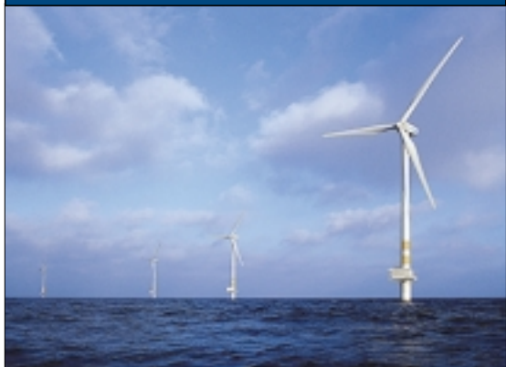
Abb 9: Offshore Park Utgrunden in der schwedischen Ostsee (GE Wind Energy)
